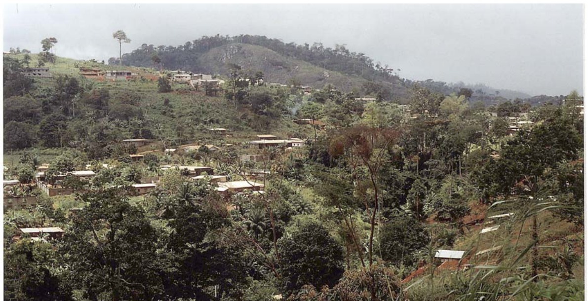
Un « grignotage » anarchique et progressif des pentes boisées en dépit de nombreux risques
